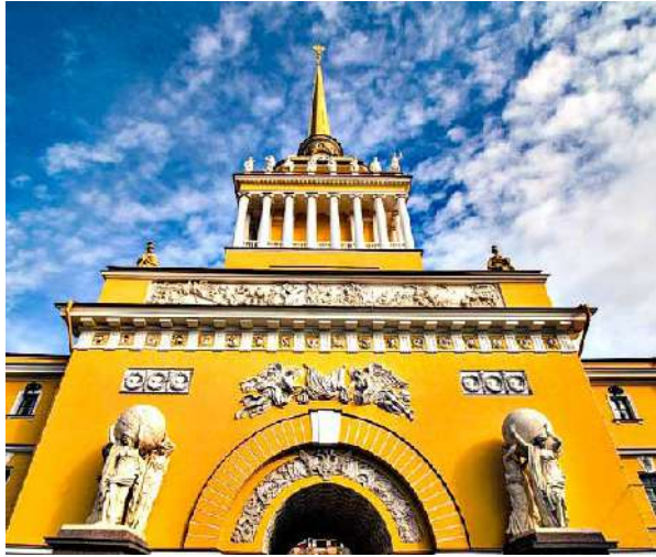
Çarlık Bahriyesi Amirallik Binası
